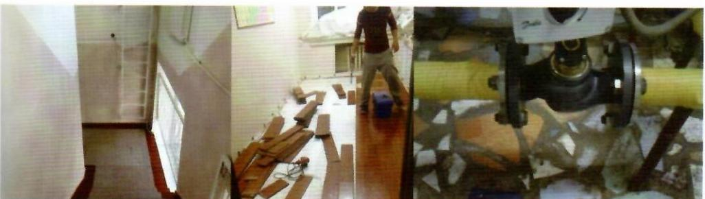
IV байрны цайны газарруу явсан халаалтын шугамд ф50d бөмбөлгөн хаалт 2 ширхэг, люкэнд ус буулгагч ф32d хаалт 1 ширхэг, өрөөнүүдэд хэвтээ ф15d шугам l-8м, босоо ф20d шугам L-12 м шугам сольсон. Мөн 14 тооны өрөөнд ф25d, ф20d-тэй 25 ширхэг изгон, винтель ком солих зэрэг ажил хийв.
