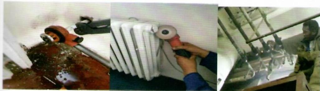
XII байрны цэвэр усны шугамд ф15d винтель 10 ширхэг, галын гидрантын ф50d хаалт 3 ширхэг, өрөөнүүдэд ф15d изгон 20 ширхэг, ф15d винтель 20 ширхэг, ф20d изгон винтель 10 ширхэгийг тус тус сольж шинэчилсэн.
