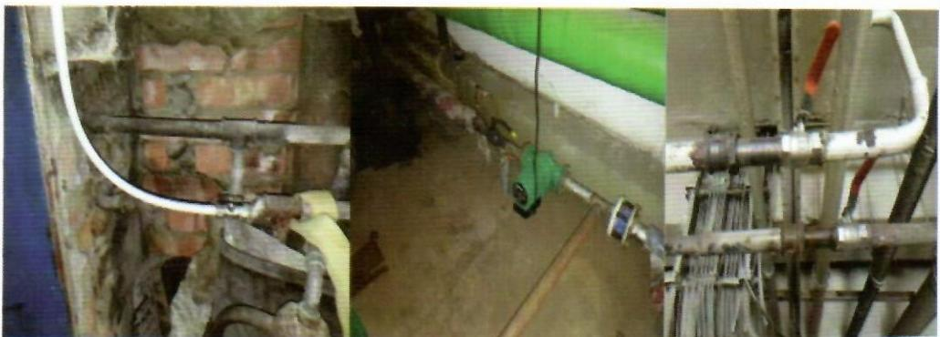
Засгийн газрын XI байрны халуун усны насос шатсаныг шинэчилснээс гадна 20-ын диаметртэй хаалт мөн шинээр тавьснаар шугам хоолойн эвдрэл гэмтлийг багасгав.
