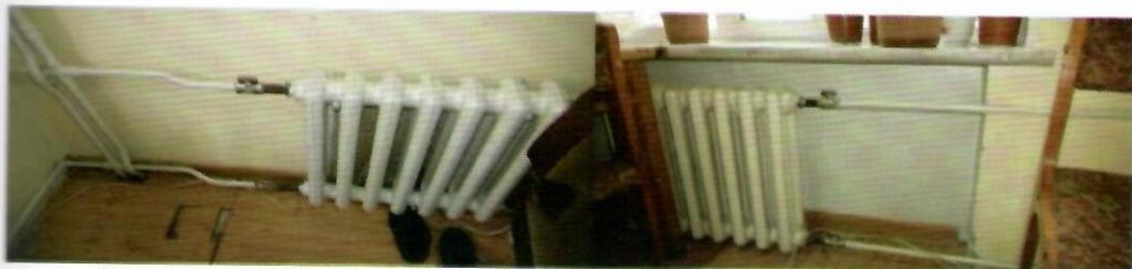
Засгийн газрын XII байранд АМГТГ-ын цэвэр усны шугамд ф15d винтель 10 ширхэг, галын гидрантын ф50d хаалт 3 ширхэг, өрөөнүүдэд ф15d изгон 10 ширхэг, ф15d винтель 10 ширхэг, ф20d изгон винтель 5 ширхэг тус тус сольж шинэчилсэн.
